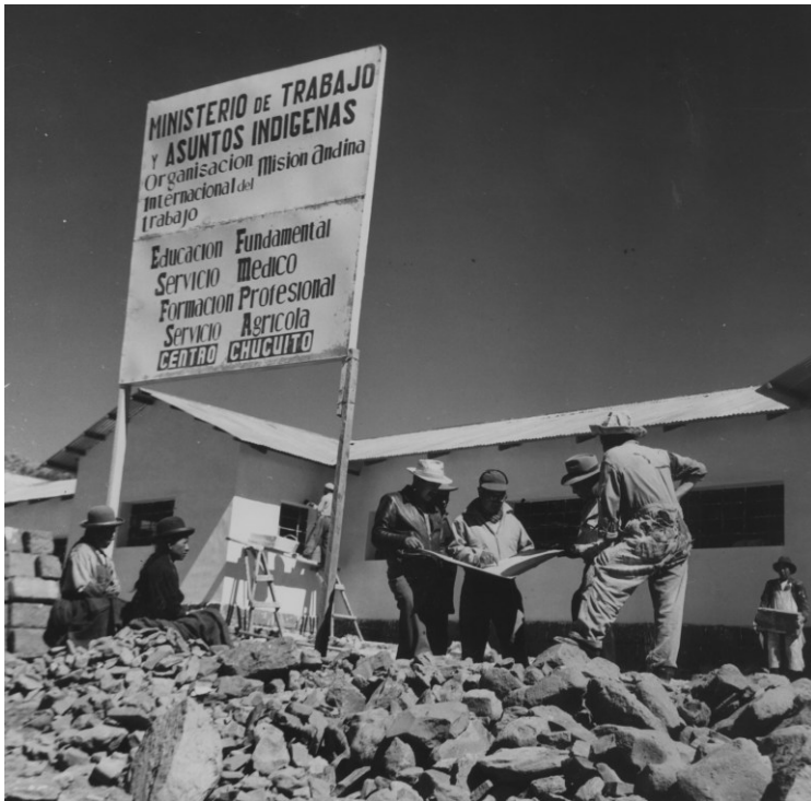
Abbildung 16: Das Foto zeigt unter anderem das Bauschild bei den Arbeiten am Zentrum des PIA in Chucuito, in Puno (Peru), vermutlich aus dem Jahr 1958. Das Schild weist auf die institutionellen Träger des Zentrums sowie das anvisierte Spektrum von Tätigkeiten hin. (Quelle: ILO Archiv Genf, Mappe: „Abbas Ammar Collection“, 1957-1961).
